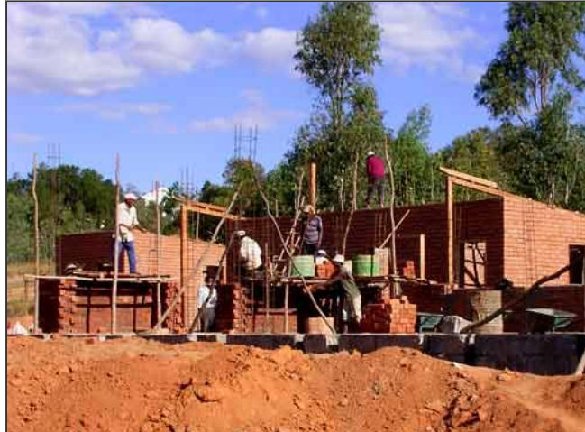
Bauarbeiten am Saal (im Vordergrund) und Wirtschaftsgebäude (Hintergrund)
