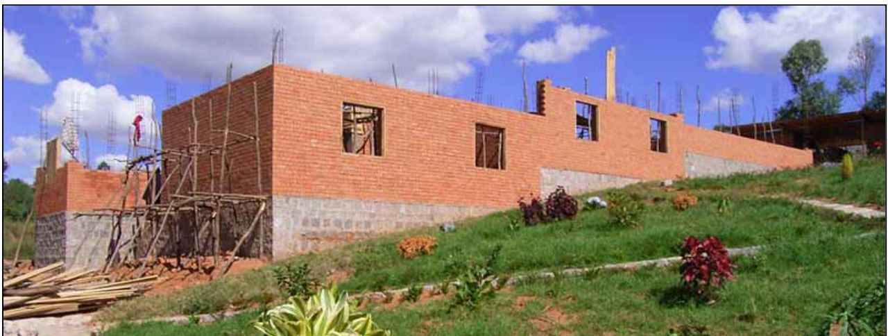
Das Schlafgebäude im Bau (Blick von Nordosten)
