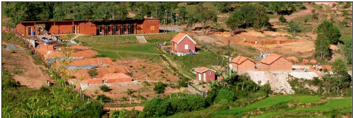
Antseranantsoa im Februar 2006 : Oben Speisesaal und Wirtschaftsgebäude. Links die Terrassierung für das Schlafgebäude (in 3 Stufen). Rechts unten die Ställe im Bau.
